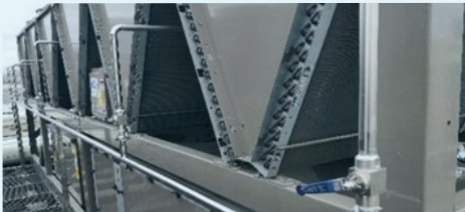
風冷熱泵翅片噴淋散熱管道改造
